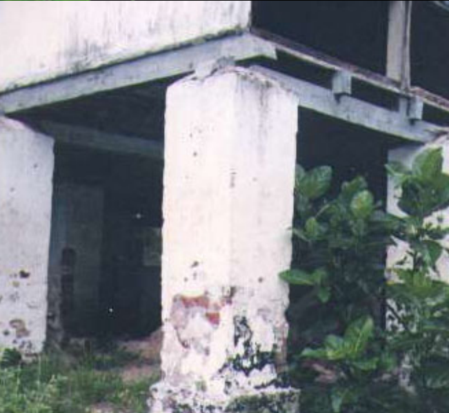
Detail konstruksi tiang pondasi dengan balok lantai
