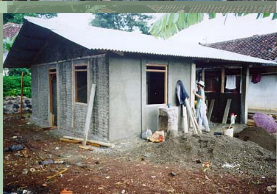
TAHAP 3: Pemlesteran rumah bambu menjadi rumah bambu plester
