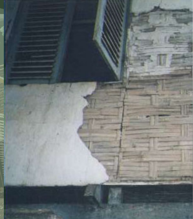
Detail konstruksi sambungan antar anyaman dan dengan rangka
