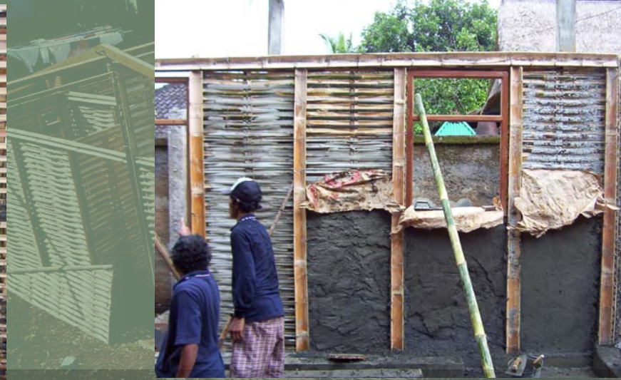
Prototipe dinding bambu plaster di EBF, Bali, 2005
