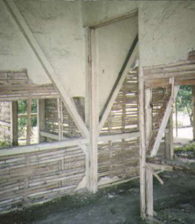
Rangka dinding terlihat pada satu sisi dan tertutup pada sisi lainnya
