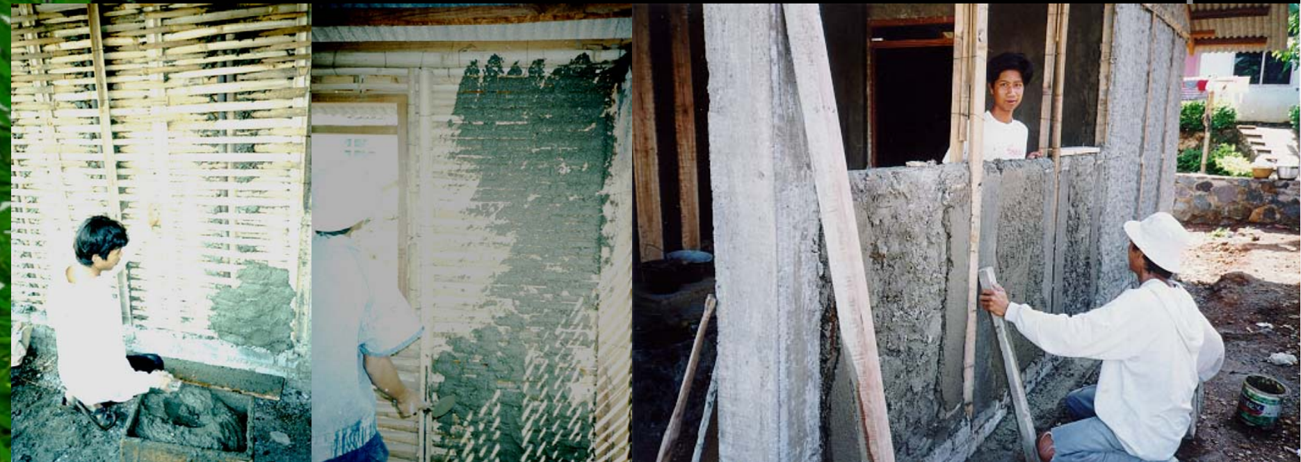
TAHAP 3: Pemlesteran rumah bambu menjadi rumah bambu plester
