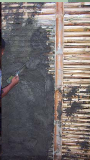
Prototipe dinding bambu plaster di EBF, Bali, 2005
